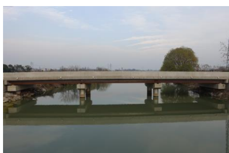
湖州市草荡新桥，耐候钢-混组合梁延伸桥面板桥（2015）
