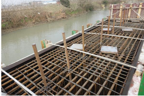
湖州市红军新桥，耐候钢-混组合梁整体桥（在建，2018 完成，其余两座今年开建）
