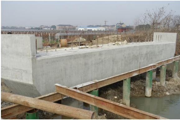
湖州市红军新桥，耐候钢-混组合梁整体桥（在建，2018 完成，其余两座今年开建）
