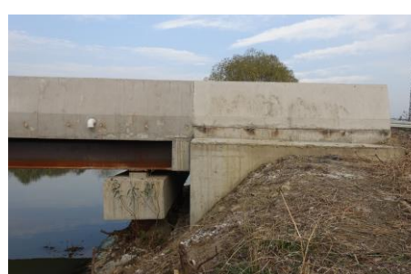
湖州市草荡新桥，耐候钢-混组合梁延伸桥面板桥（2015）
