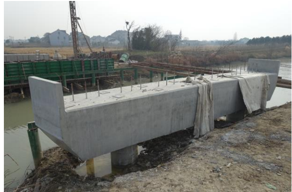
湖州市红军新桥，耐候钢-混组合梁整体桥（在建，2018 完成，其余两座今年开建）
