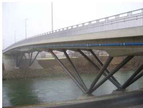
Figure 13. View of the Seitenhafenbrücke
