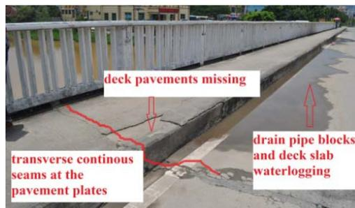
Fig.10. Deck drain malfunction
